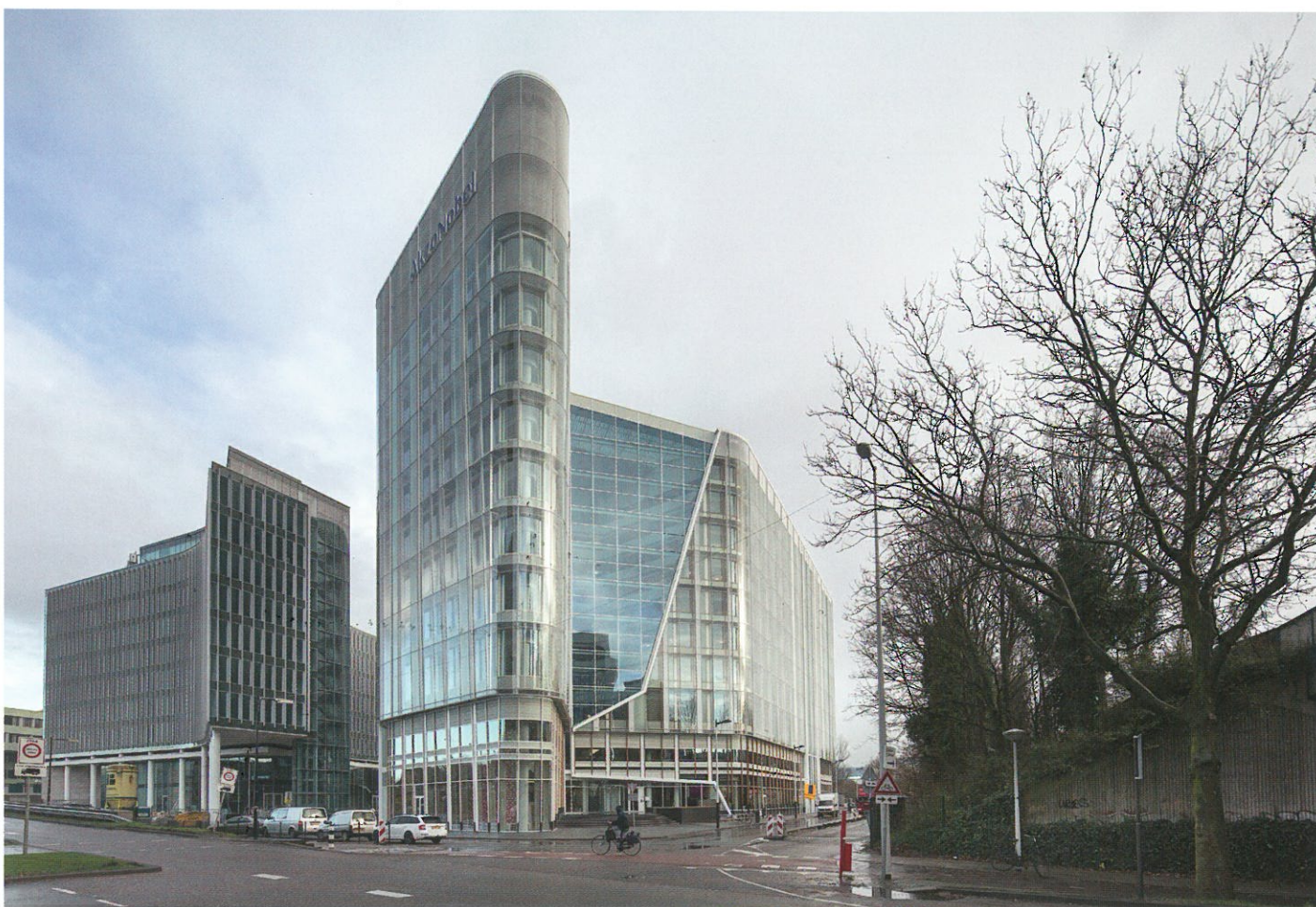
Een prominent gebouwdeel is de afgeronde glazen punt die vooroverheft. De hoek is als een denkbeeldige cilinder geconstrueerd.
