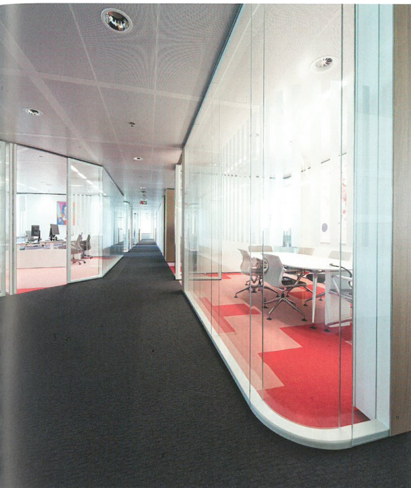
De vergaderkamers hebben ronde hoeken van twee lagen gebogen glas.
