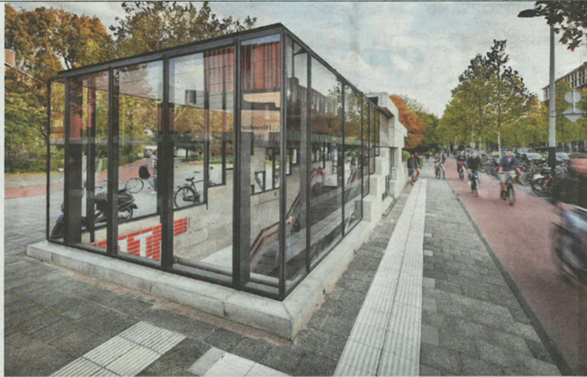
Entree van het gerenoveerde metrostation aan de Wibautstraat, met glazen opbouw.
