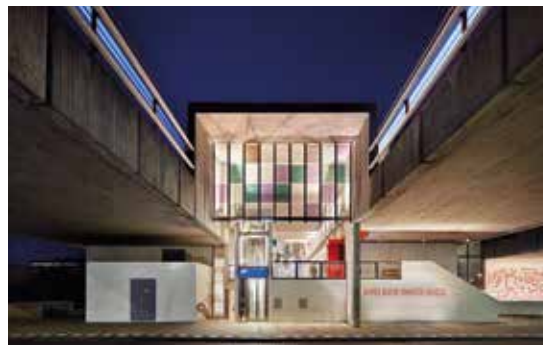
Eingangsbereich zur oberirdischen Haltestelle Van der Madeweg © Digidaan
