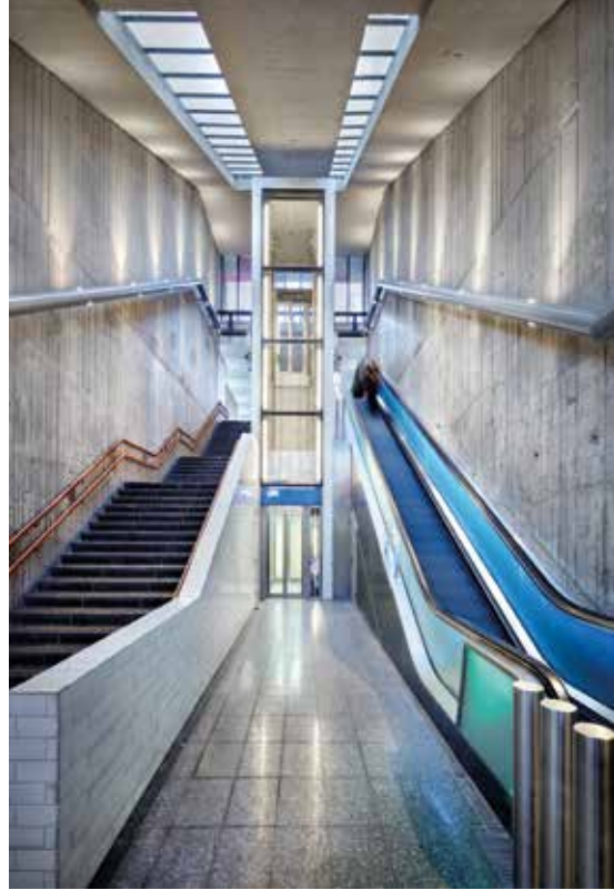
... und nach der Sanierung © Digidaan
