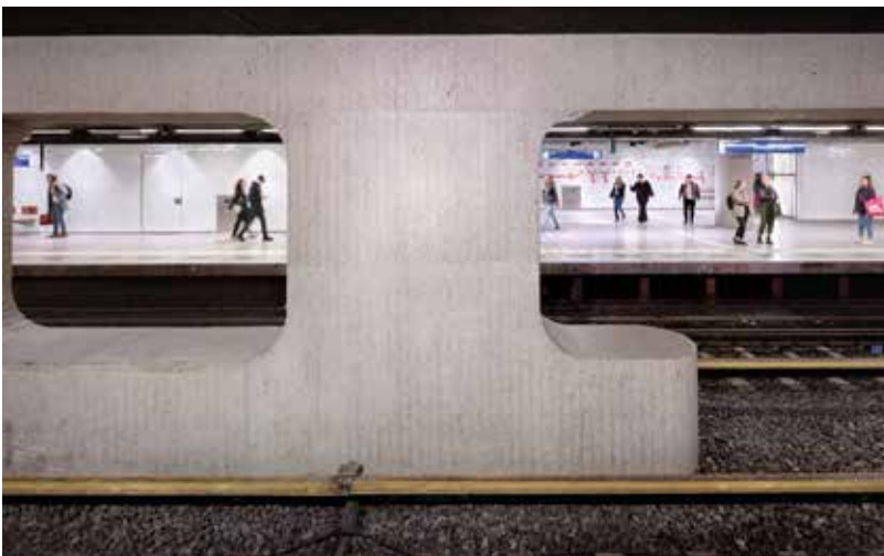
Sichtbetonflächen in unterirdischer Station Weesperplein © Digidaan
